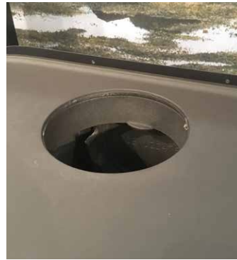
Asennus liitoksen sisään
